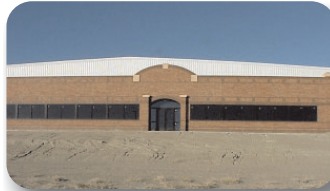
BENSHAW Pueblo Trane Division Pueblo, CO
